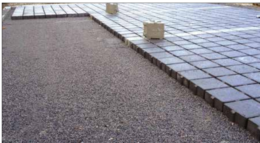
Udlægning af sten på permeabelt underlag. Bemærk det grove afretningsmateriale.
