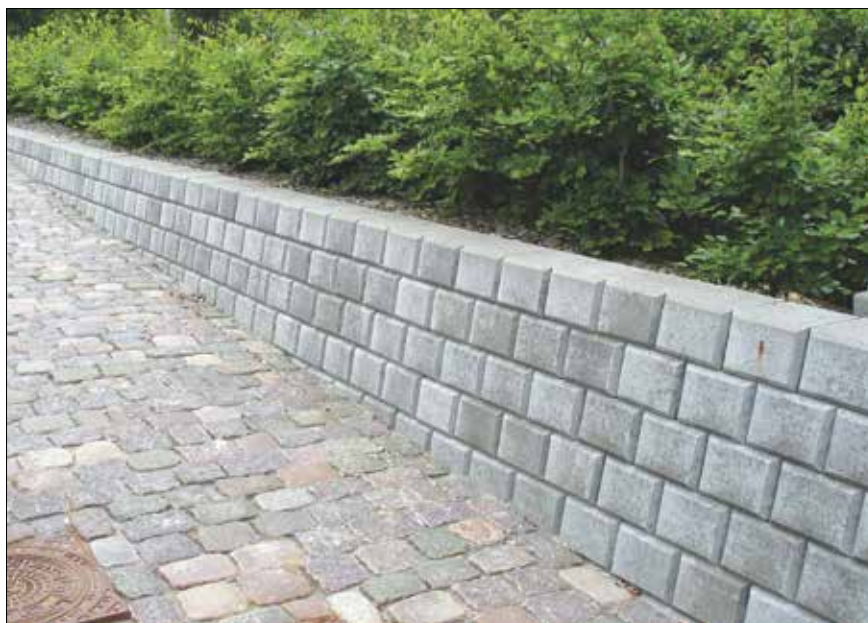
Her er støttemursblokkene anvendt i forbindelse med en rampe der forbinder 2 forskellige niveauer.
