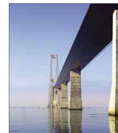
Storebæltsbroen som forventes at holde i 100 år, er blandt andet udsat for frost kombineret med saltpåvirkning.
