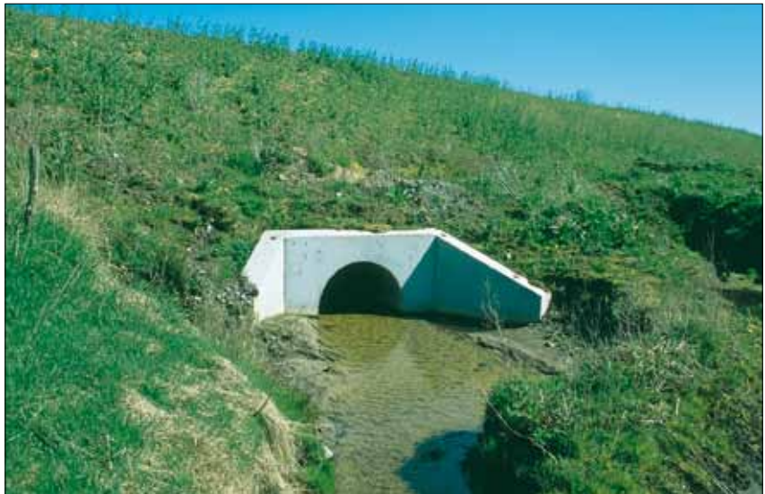
Udløbsbygværker er også komponenter, som typisk vådstøbes.
